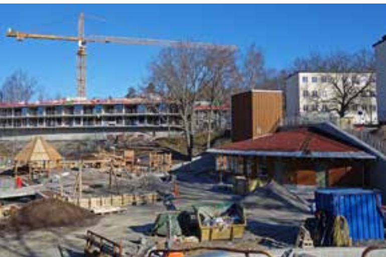
Hisstornet sticker upp. I bakgrunden byggprojektet Bergsvåg.
