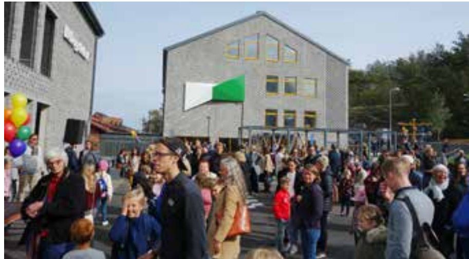
Bobergsskolans två nybyggda hus.
