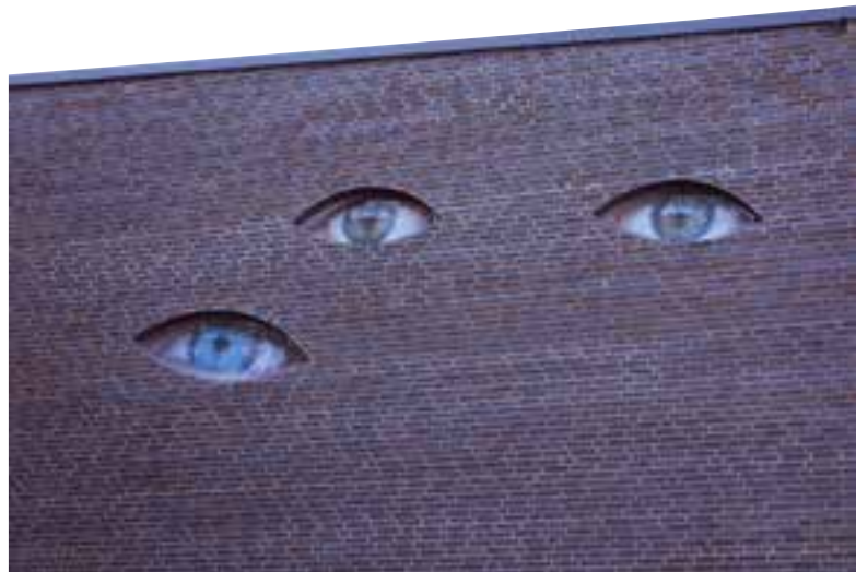
Hjorthagshallen ligger i direkt anslutning till Hjorthagens IP. Fasaden mot norr pryds av dessa ögonformade fönster.
