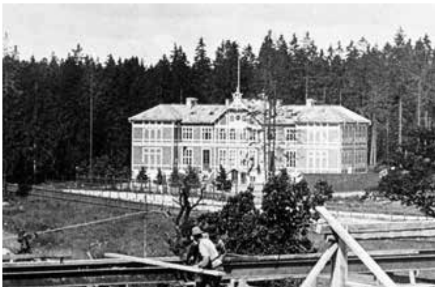
Träskolan framför den kompakta barrskogen. Bilden tagen från Elektricitetsverkets bygge.
