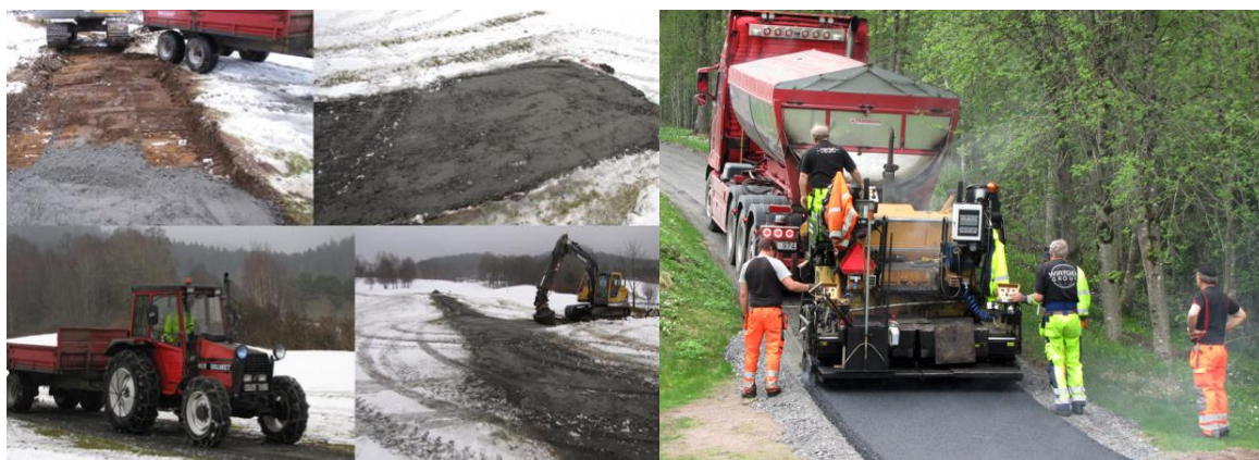
Bildtext: Tillgänglighetsanpassning pågår: asfaltering av gångvägarna på Hulda golfklubb. Foto: Jan Jeansson
