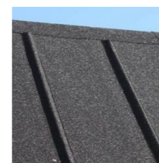
Mörka tak Ex. takpapp, plåt, takpannor
