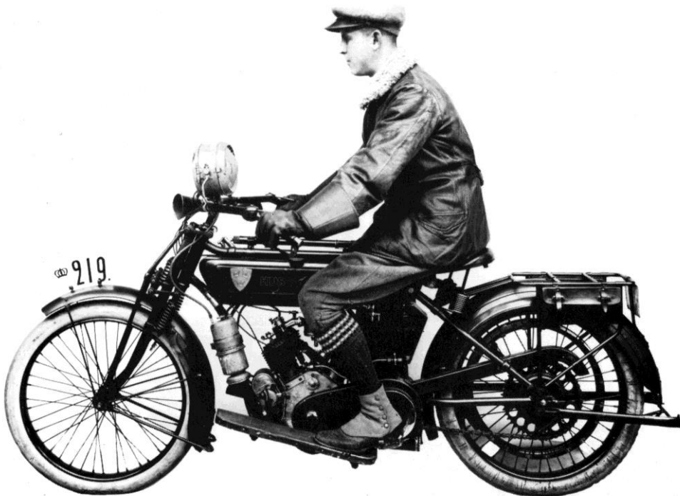
HVA arméleverans 1916, modell 145 med Moto-Reve tvåcylindrig V-motor på 548 cc. TM.
