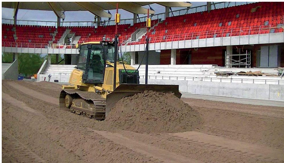
Bild tagen från anläggningsarbete vid Myresjöhus arena
