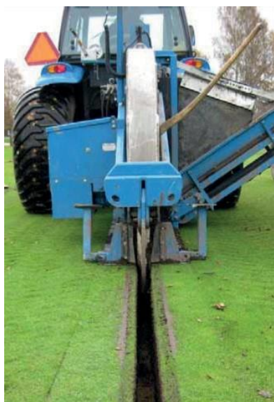
Grävhuyl för dränering
