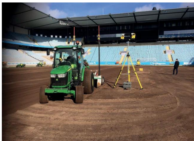
Planeringsarbete Swedbank Stadium
