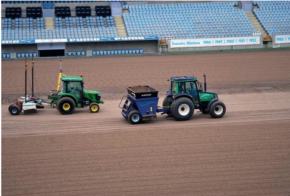
Planeringsarbete Swedbank Stadium
