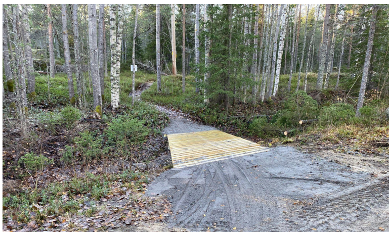
Fig. 9. Bro över vägdike
