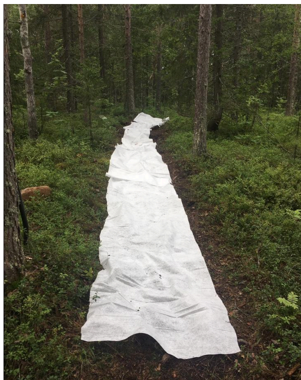
Fig 6. Markduk under stenmjölet ger en hållbarare led.
