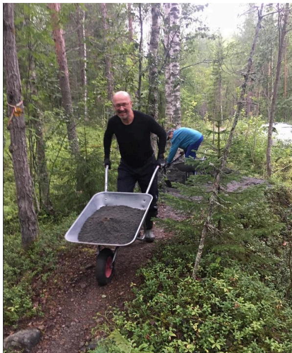
Fig 5. Allt stenmjöl fördelades manuellt på leden
