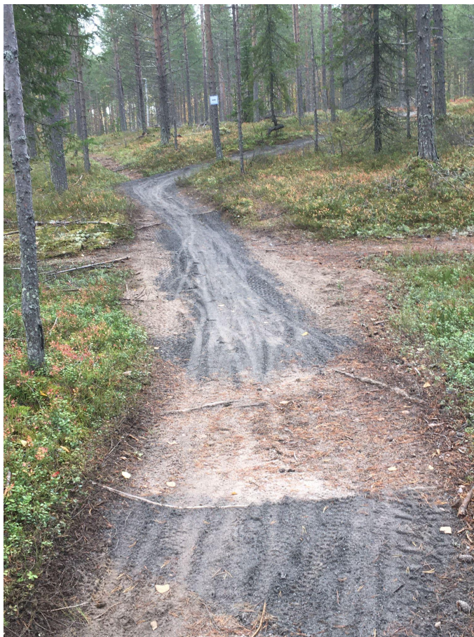
Fig 3. Förstärkning av hårt slitna partier på Hagadalsleden
