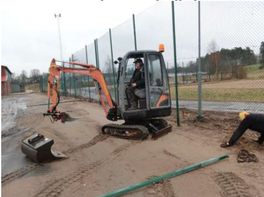
Dräneringsdike klart för igenläggning
