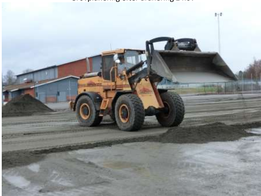
Grovplanering efter dränering 2 nov
