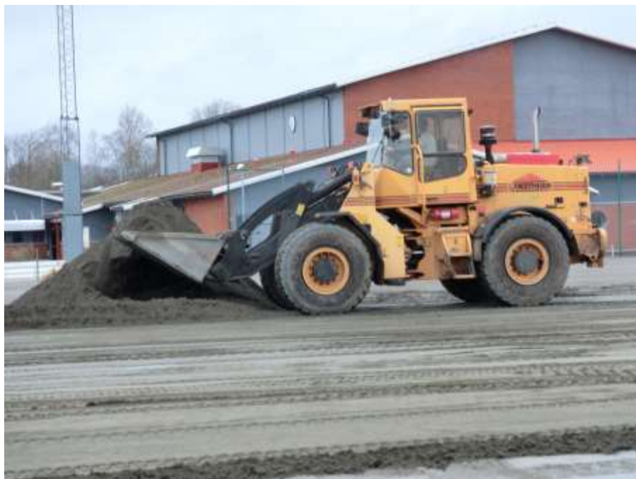
Grovplanering efter dränering 2 nov
