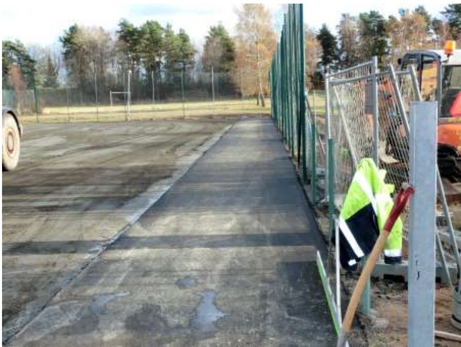
Asfalt kant på plats 6 nov
