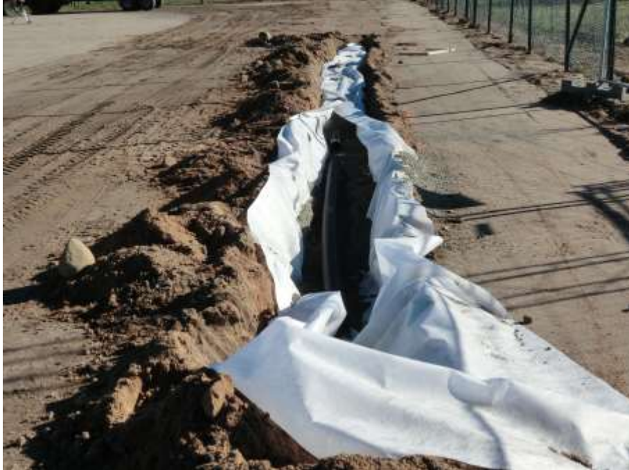
Dräneringsdike klart för igenläggning
