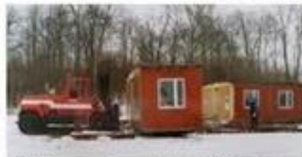
När klubbhuset skulle byggas vid Vretalunds IP kom det på viljor som sattes ihop. Byggnadsprocessen drog i gång i början på 1990-talet. FOTO PERUK
