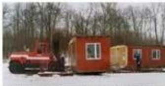
När klubbhuset skulle byggas vid Vretalunds IF kom det på viljor som sattes ihop. Byggnadprocessen drog i gång i början på 1990-talet. FOTO: PERIK
