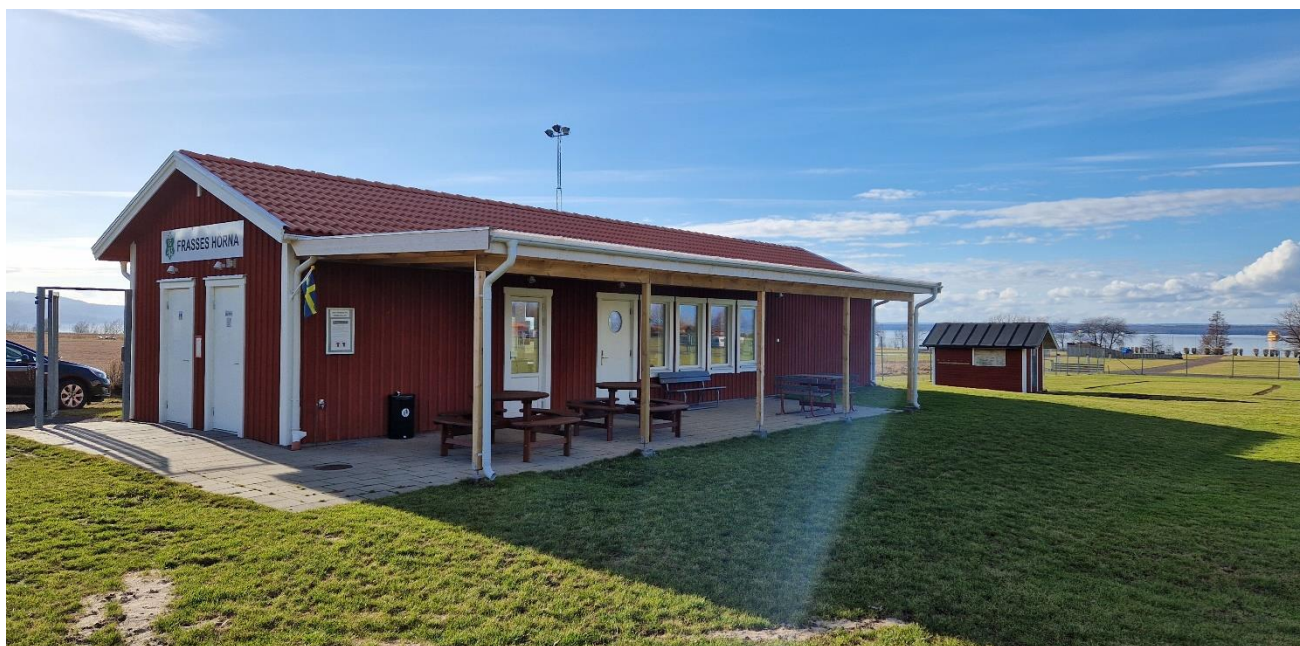
Frasses hörna med nya taket.
