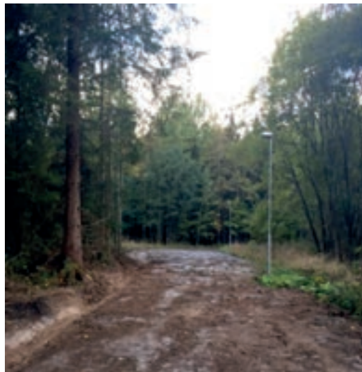
Breddning av spåret.
