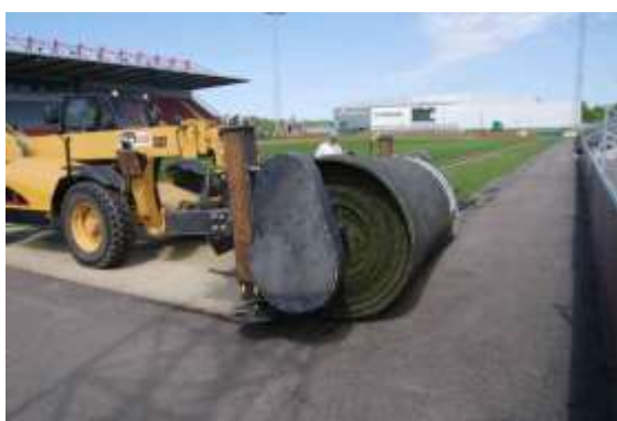
Exempel på borttagning av konstgräs med fyllnadsmaterial
