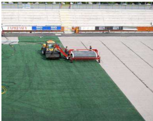
Exempel på borttagning av konstgräs utan fyllnadsmaterial
