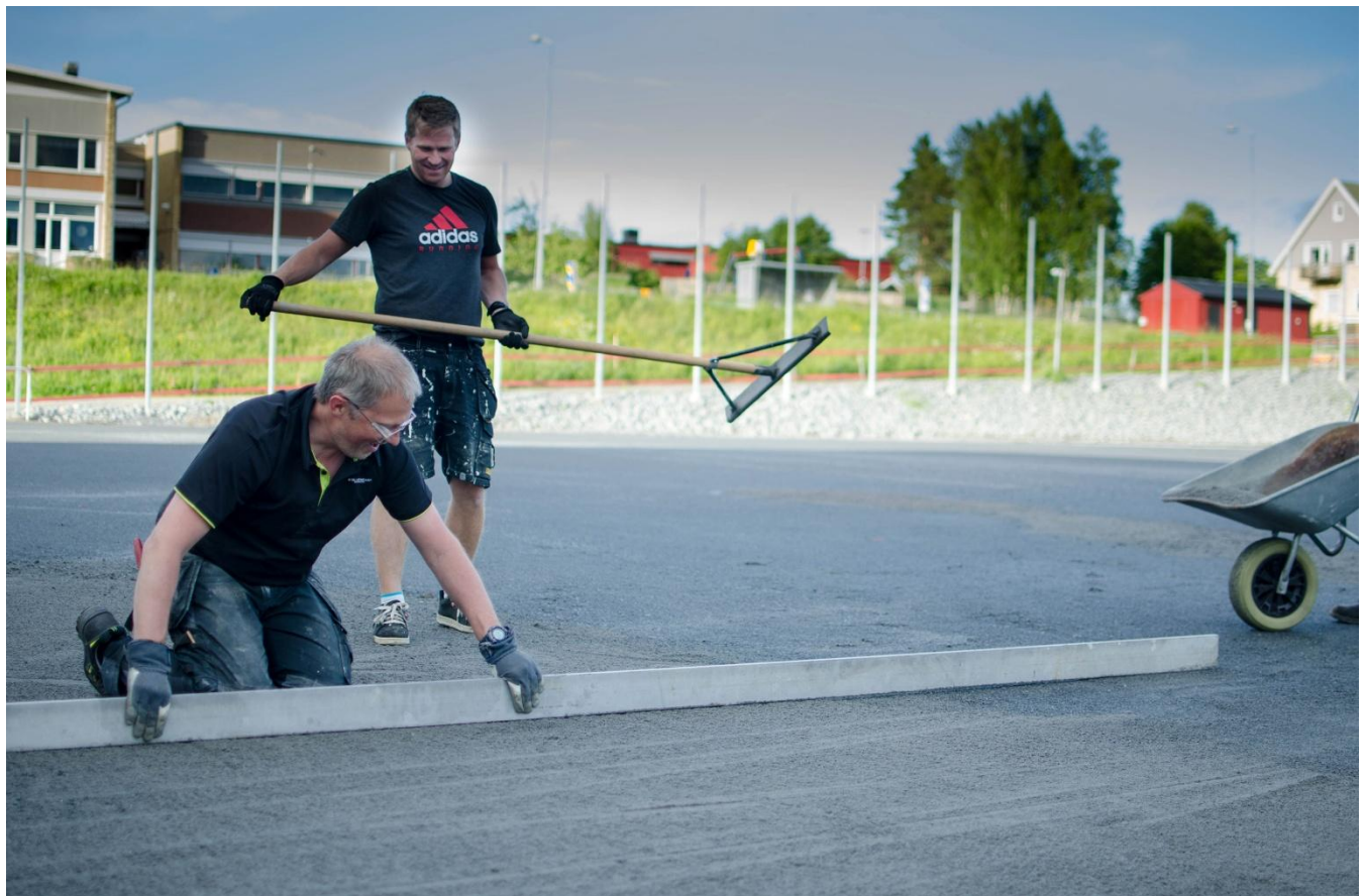
Groparna har fyllts med finaste 0-4 material
