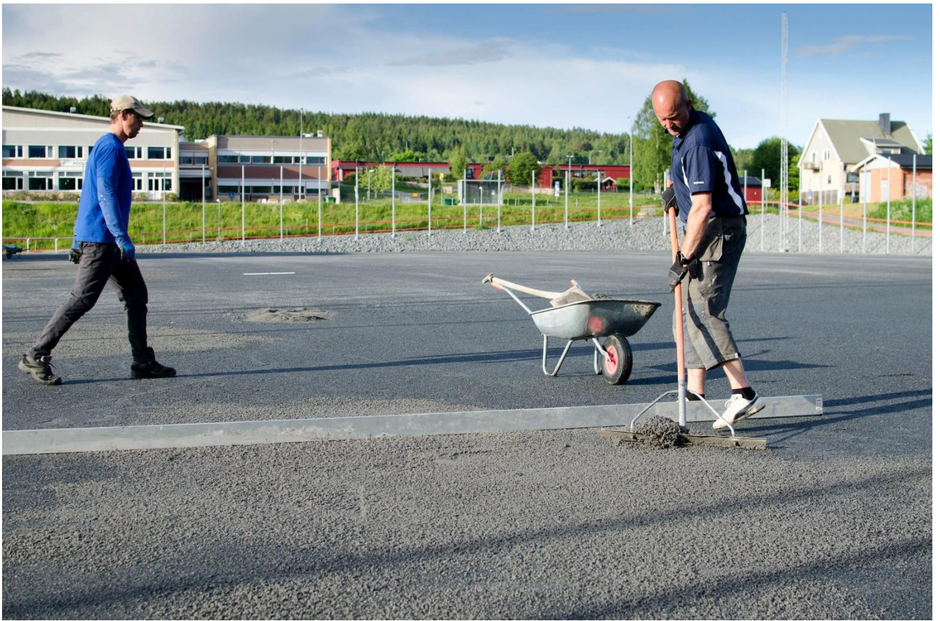
Groparna har fyllts med finaste 0-4 material
