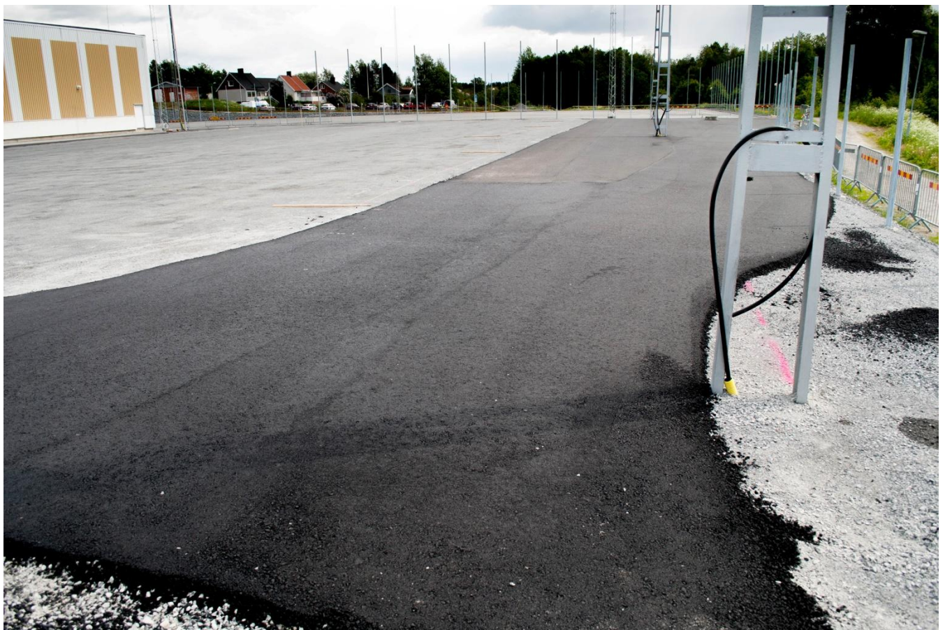
Asfaltering runt isbanan
