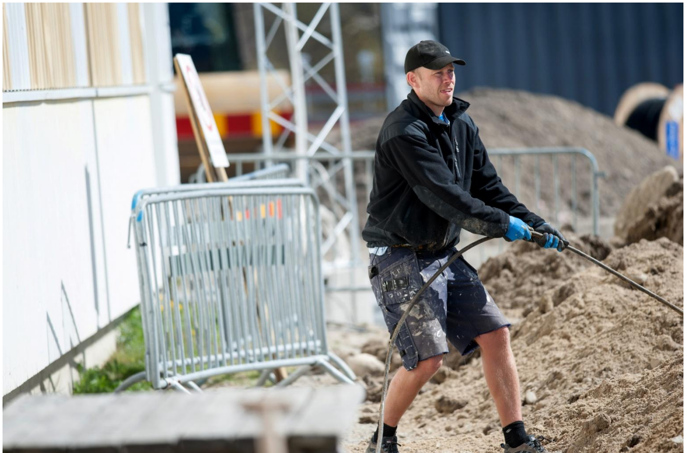
Eldragning till belysningsstolpar 7 manna
