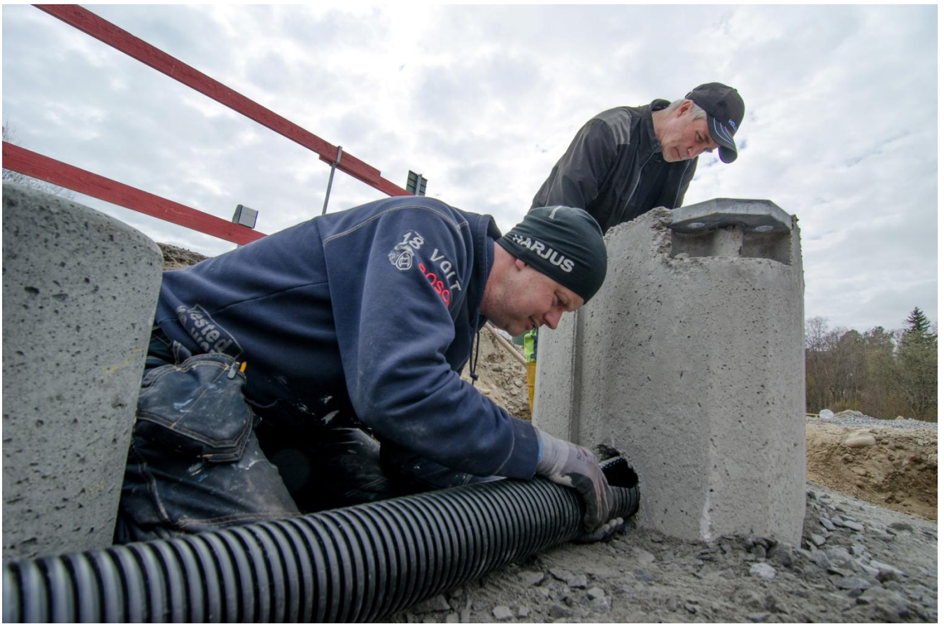
Anslutning av kabelrör till fundament för belysning
