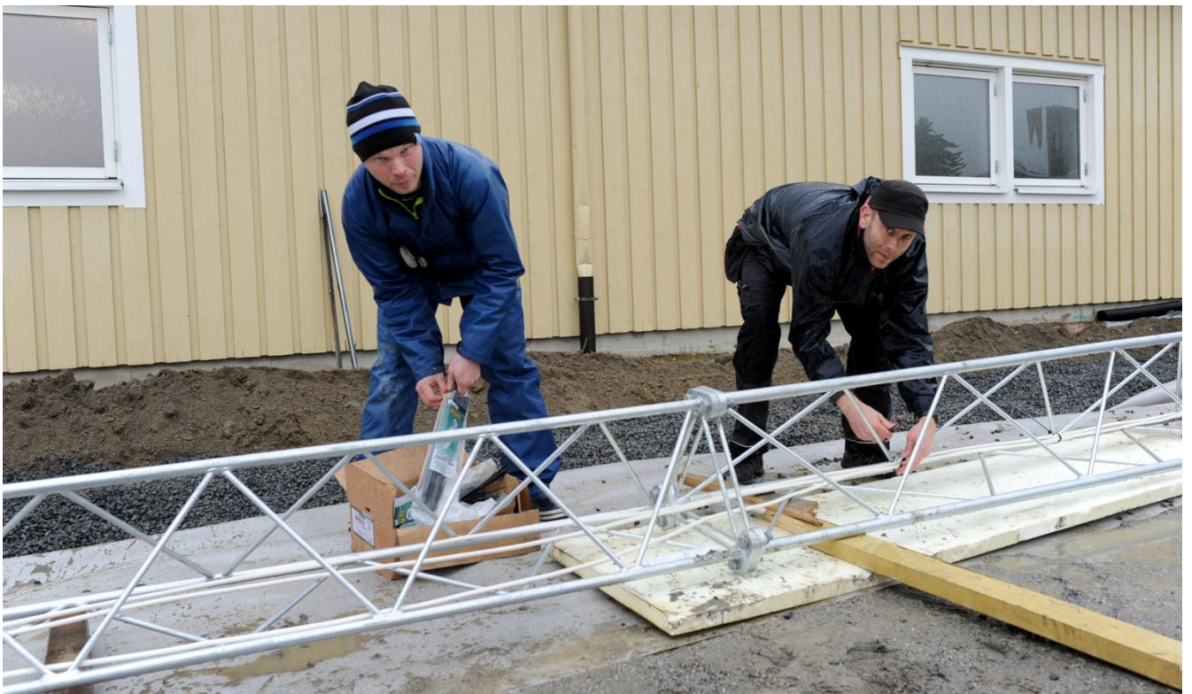
Ihopmontering av belysningsstolpar
