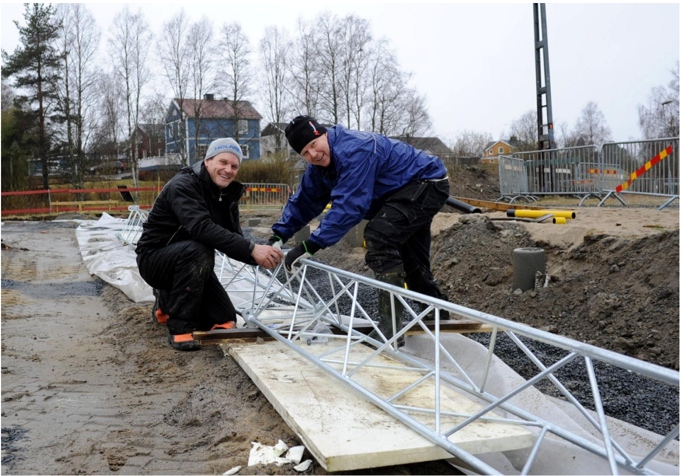
Ihopmontering av belysningsstolpar
