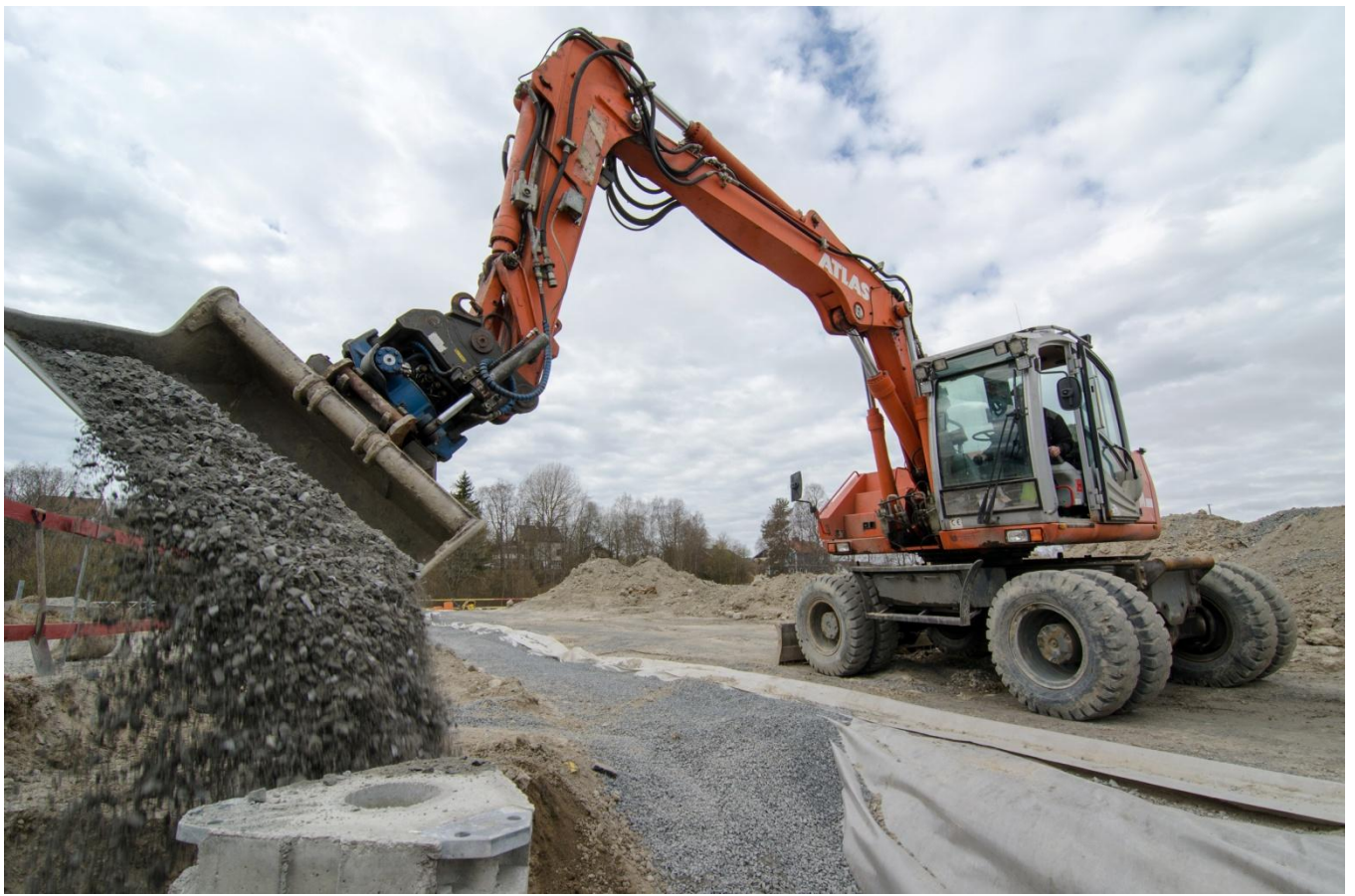
Fylla igen det sista och gräva kabeldike.
