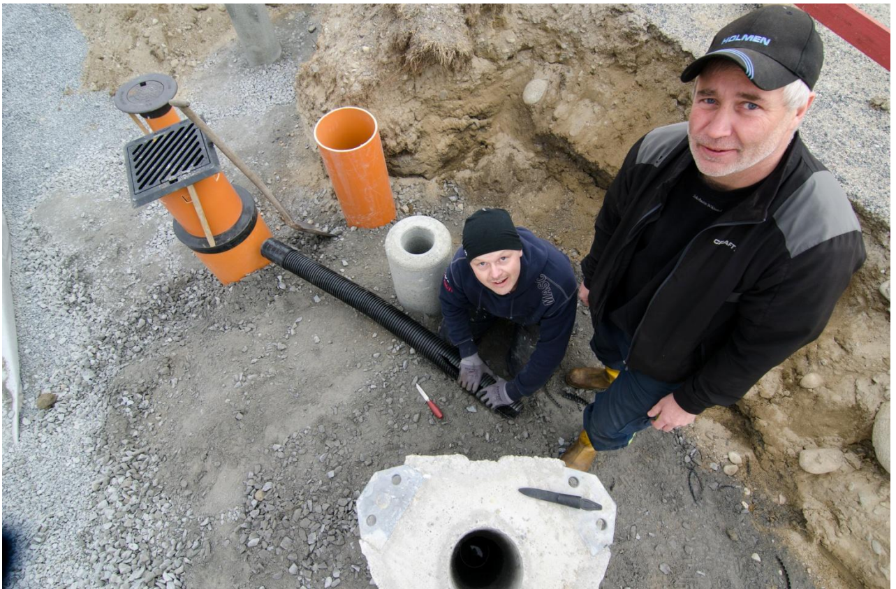
Anslutning av kabelrör till fundament för belysning
