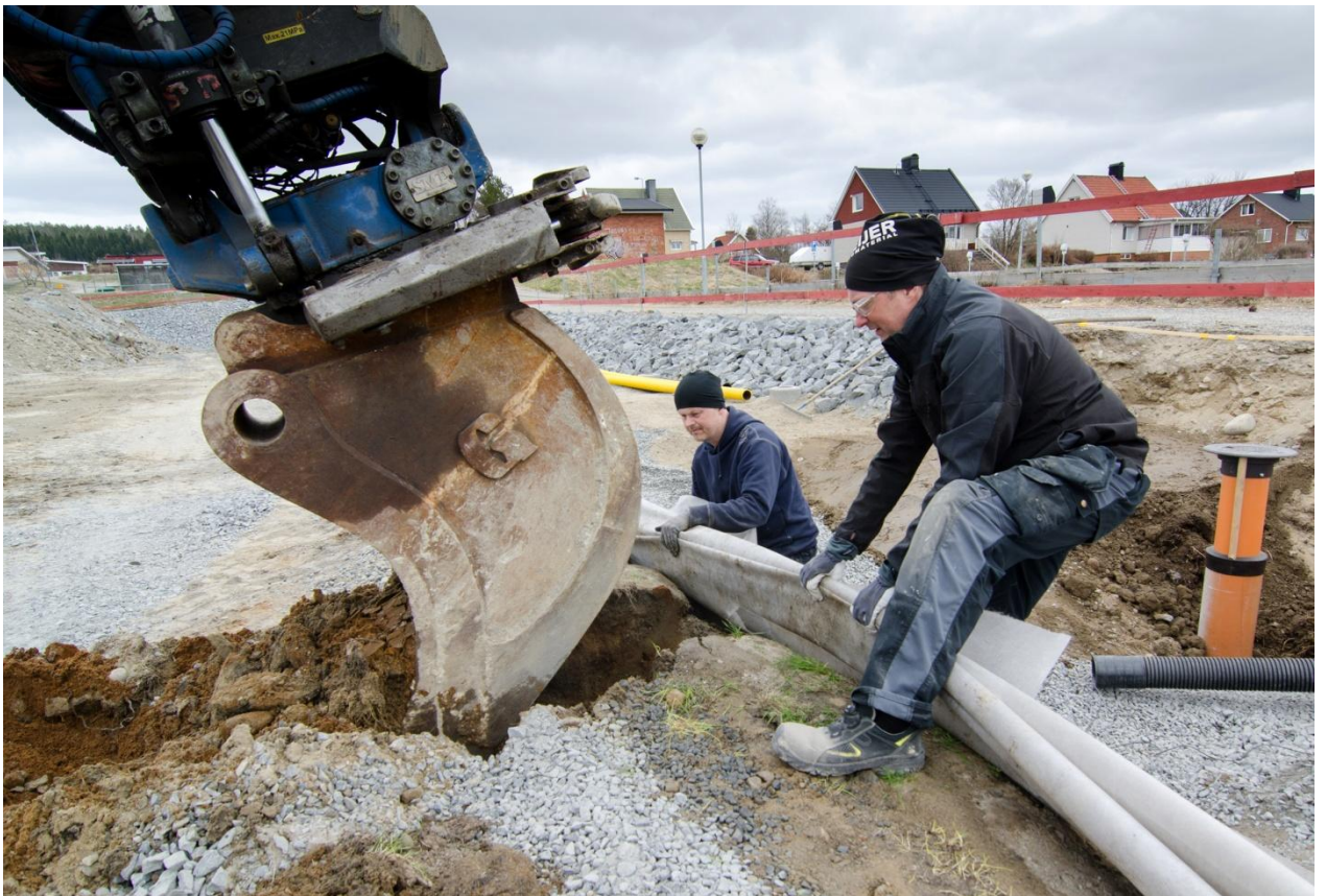
Fylla igen det sista och gräva kabeldike.
