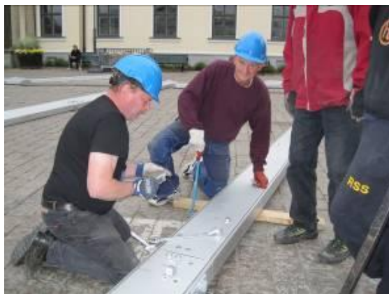
Bengt Johansson och Nils Gård bygger spant
