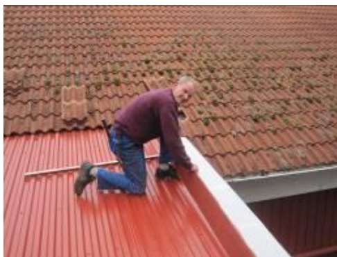
Bengt – "Mannen på taket"-bygger carport
